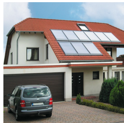
Capteurs solaires WTS-F1 en intégration de toiture
